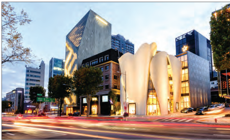
Gangnam városrész, Cheongdam-dong negyed, Dior Ház épülete, Szöul
