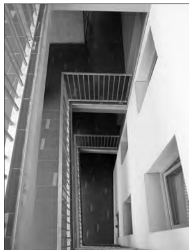
A függőfolyosókat a homlokzattól elhúzták
