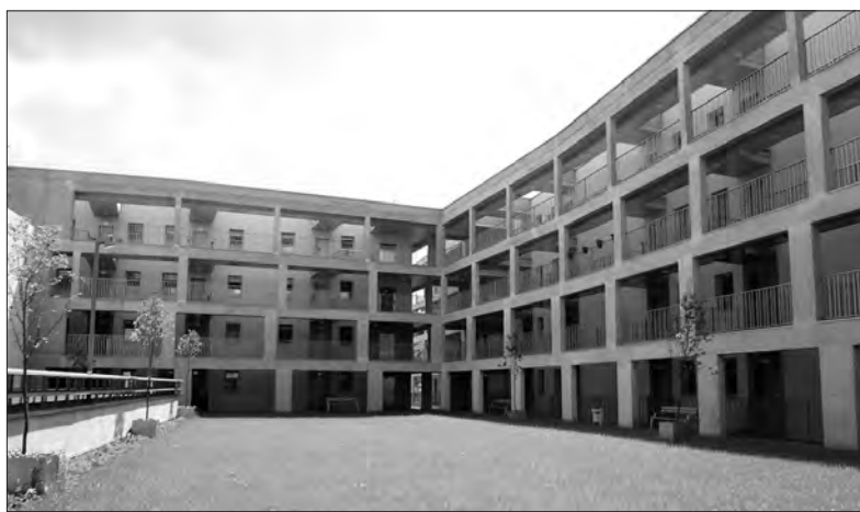
A belső udvar a hagyományos függőfolyosókkal
