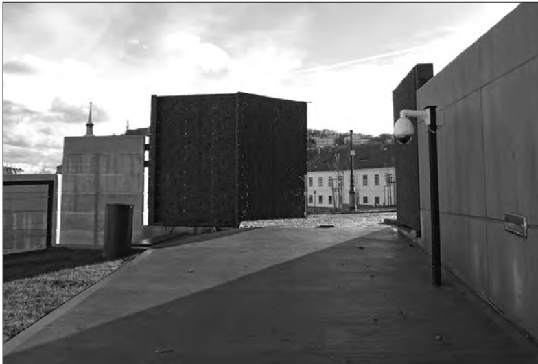
A kortárs építészet jelenléte: cortenacélból készült ajtó és kapu
