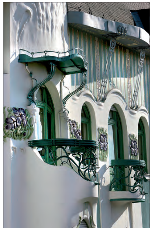
A homlokzat részlete
